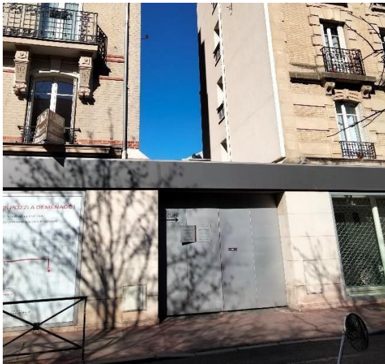
Accès depuis la rue Aristide Briand
