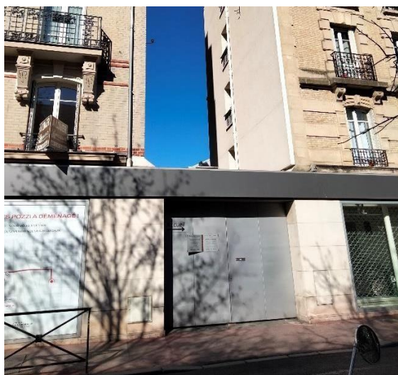
Accès depuis la rue Aristide Briand
